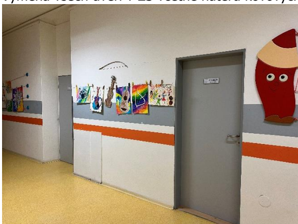
Výměna všech dveří v ZŠ včetně nátěru kovových zárubní:
